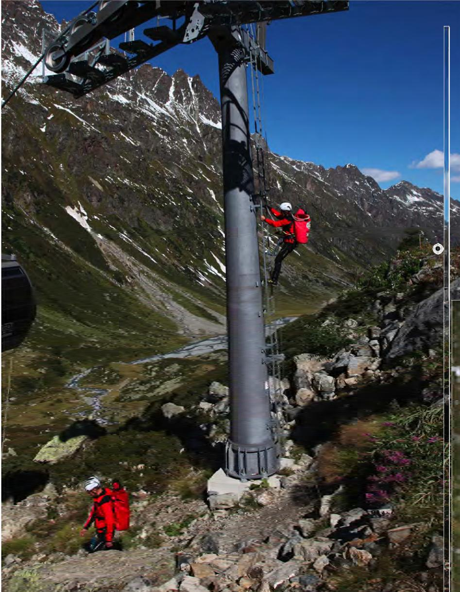
Nachdem 2005 das erste System der Bergrettung Tirol entstanden ist, folgt nun ein weiteres System. Die großen Fahrbetriebsmittelabstände machen dies notwendig. Um mit dem gleichen System wie bisher arbeiten zu können erfolgt eine kleine Adaptierung.
