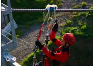
Die kurze Selbstseilrolle wird bis zum Maximum **verlängert**. Die Selbstseilrolle vom Seilaufwerk wird bis zum Maximum **verkürzt**.
