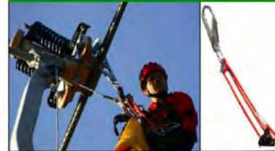
Der Karabiner der kurzen Selbstseilrolle wird vom Liftseil ausgehängt und am Gurt eingeklinkt.
