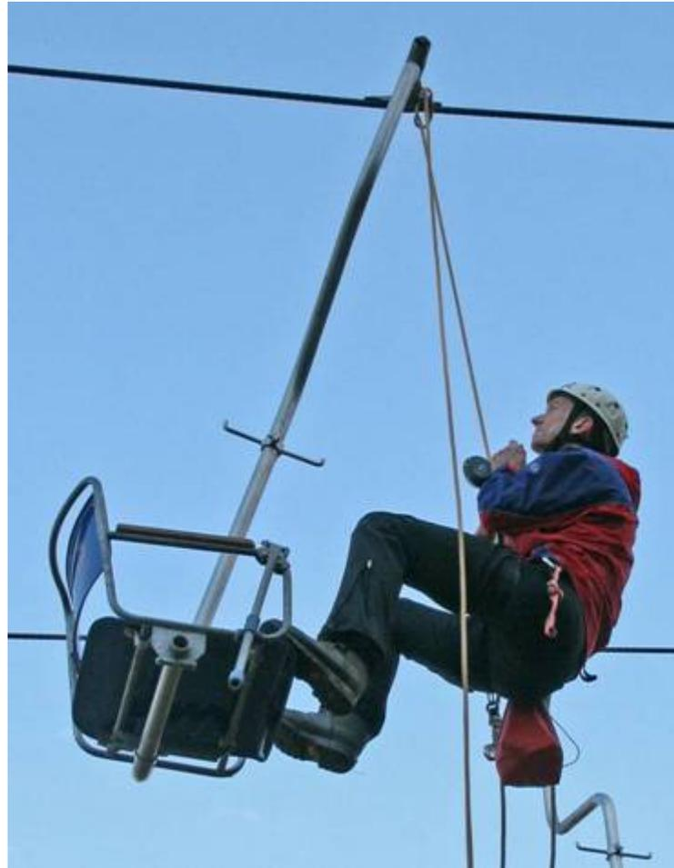
Seilt der Retter an gleichzeitig bewegten und belasteten Seilen ab, entstehen oft Schäden an den Fahrzeugen (Einschneiden in die Auflaufzungen der Klemmen, Schleifspuren an Kabinenscheiben oder Sesselpolstern, etc.)
